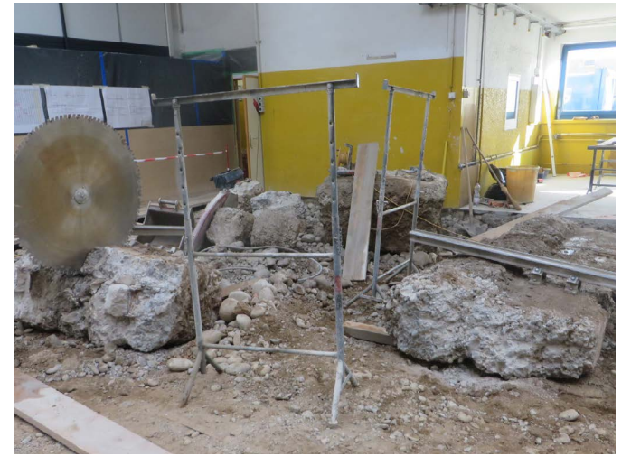
Eindrücke aus der Umbauphase
