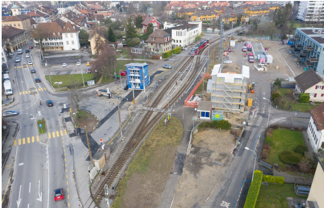
Luftaufnahme Bahnhof Nidau
