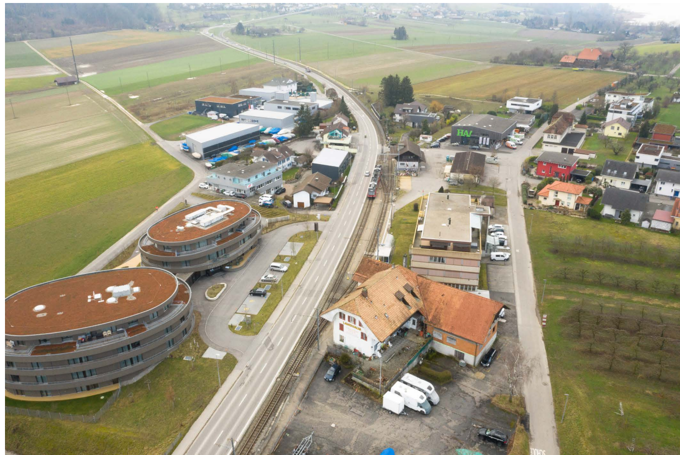
Luftaufnahme Bahnhof Lattrigen
