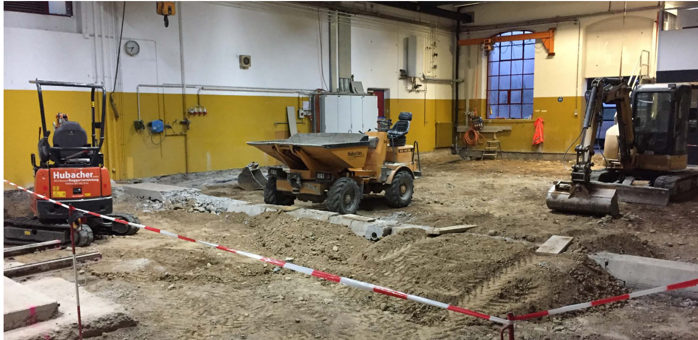
Eindrücke aus der Umbauphase
